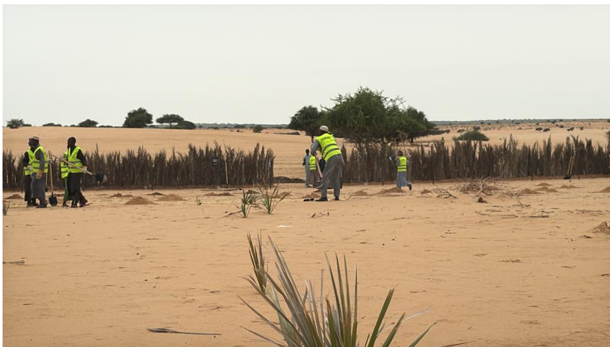
Photo 1 et 2 : Travaux de piquetage par les techniciens de la Direction des Forêts, membres de la Sous-Commission Technique
